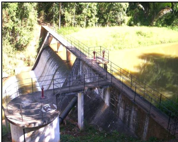
**Figura 4.2** – Captação de água superficial da COPASA. Barragem de regularização de nível no rio Pirapetinga - Julho 2006.
