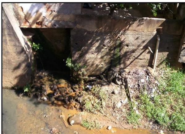
**Figura 4.8** – Lançamento do efluente da ETA, proveniente da lavagem dos filtros, no ribeirão Feijão Cru. Na ponte da rua João Neto, bairro Mina de Ouro (coordenadas em m: 743.970 UTM-E e 7.616.830 UTM-N) - Julho 2006.
