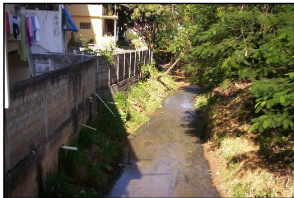
**Figura 4.13** – Lançamentos clandestinos de esgotos. Diretamente das residências, nas margens do ribeirão Feijão Cru, bairro Mina de Ouro (coordenadas em m: 743.970 UTM-E e 7.616.830 UTM-N) - Julho 2006.
