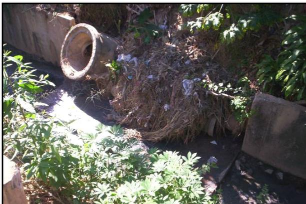
**Figura 4.15** – Canal mestre da rede de esgotos, localizado ao longo da canalização do ribeirão. Rompido e posteriormente obstruído por entulhos, e, poço de inspeção sem tampa - Julho 2006.
