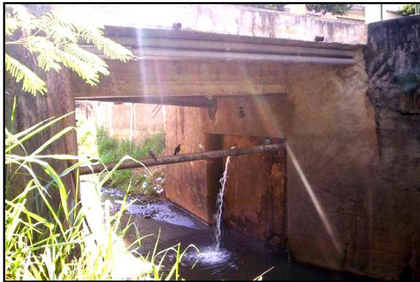
**Figura 4.14** – Tubulação de esgotos da Prefeitura rompida, sob a ponte da rua João Neto. Bairro Mina de Ouro (coordenadas em m: 743.970 UTM-E e 7.616.830 UTM-N) - Julho 2006.
