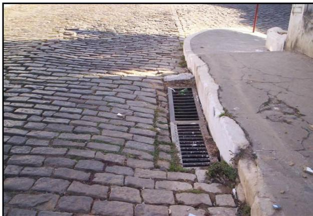
**Figura 4.23** – Bueiro com grelha localizado no centro histórico da cidade de Leopoldina. Notar a ausência de canaletas ou sarjetas para o escoamento da água – Julho 2006.
